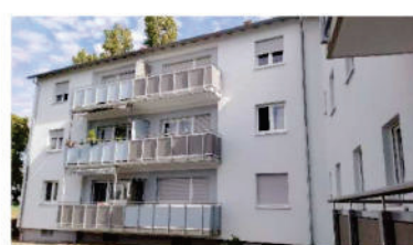
Fußgönheim, Am Dreschplatz 15/17
