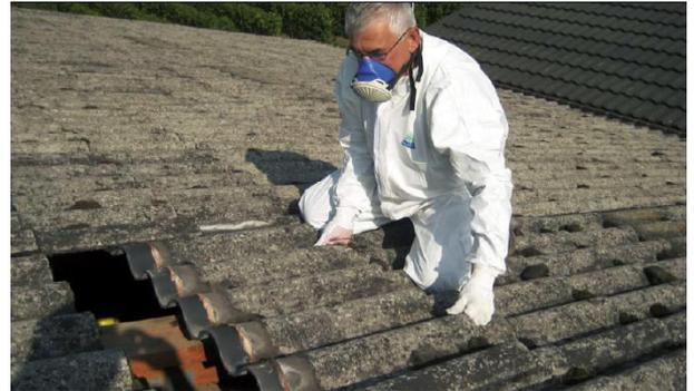
Abb. Rückbau eines Asbestzement-Daches
