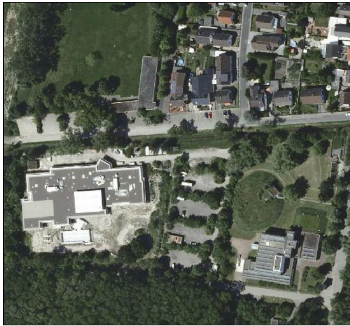
Die räumliche Nähe zwischen dem Kreisbad Maxdorf-Lambsheim (links) und dem Wasserwerk der Friedelsheimer Gruppe (rechts) macht eine außergewöhnliche Wärmeversorgung möglich.
