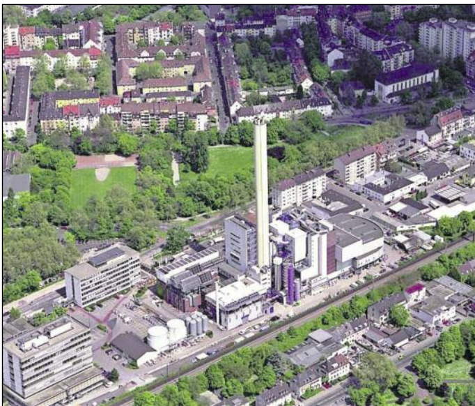
Müllheizkraftwerk Ludwigshafen der GML
