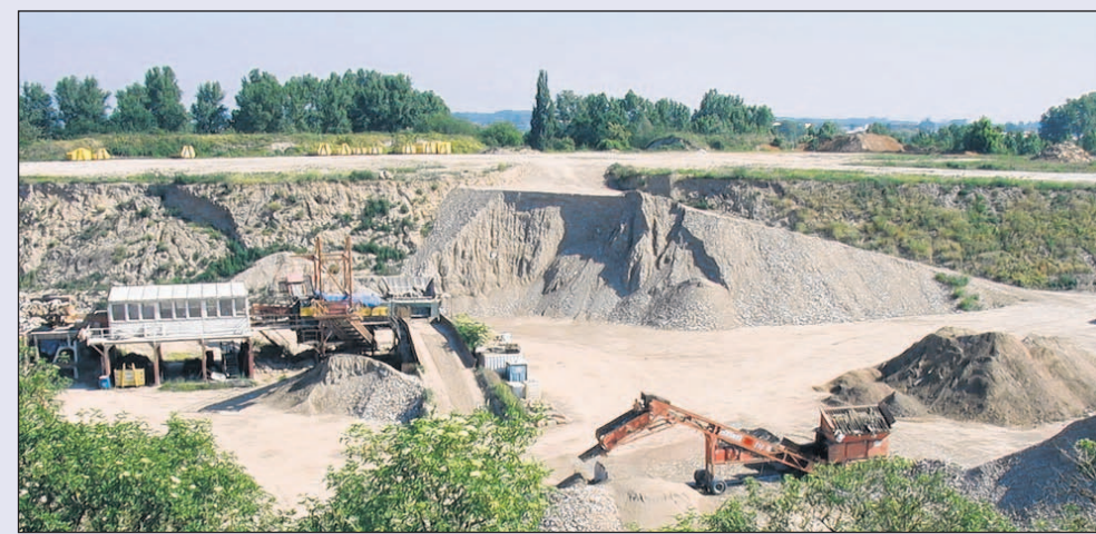
Ihre Tage sind gezählt: Die Bauschutt-Recyclinganlage am Westrand von Schifferstadt
